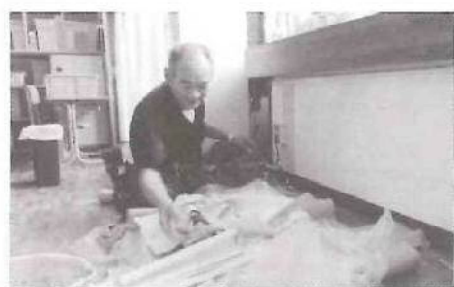
長井-学校で修繕作業
